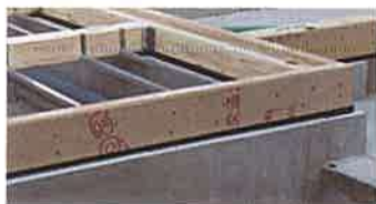
戸建・大引ネダ下部
