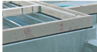
戸建・大引ネダ下部
